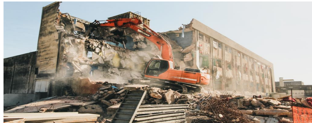
Anúncio em 19.11.2021 e OIS em 22.06.2022 Demolição e construção da Nova Cadeia
